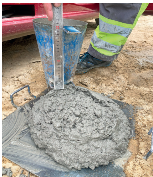
Fot. 6. Badanie konsystencji na budowie
